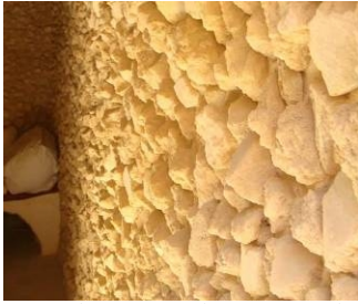
(شكل ١٧ أ) الحوائط الخارجيه من خليط كرشيف الذى تم تجفيفه ويعطى الجمال للتصميم بالاضافه انه عازل جيد للحراره. (١٩)
