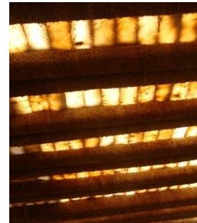
(شكل ١٩) اضاءه وتدفته الداخل باشعه الشمس، المتخلله لكتل الرمل الابيض فى السقف. (١٩)
