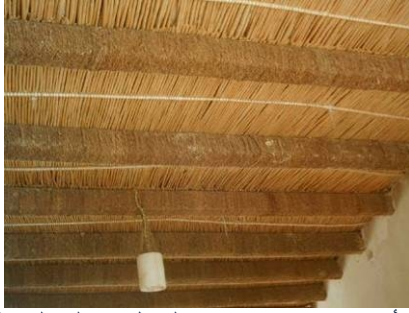
(شكل ١٥) استخدام سيقان شجر النخيل في الى المدخل حيث الاسقف يساعد تقليل الحرارة في الداخل.
