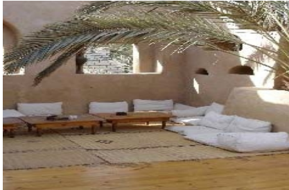
(شكل ١٧ أ) الحوائط الخارجيه من خليط كرشيف الذى تم تجفيفه ويعطى الجمال للتصميم بالاضافه انه عازل جيد للحراره. (١٩)
